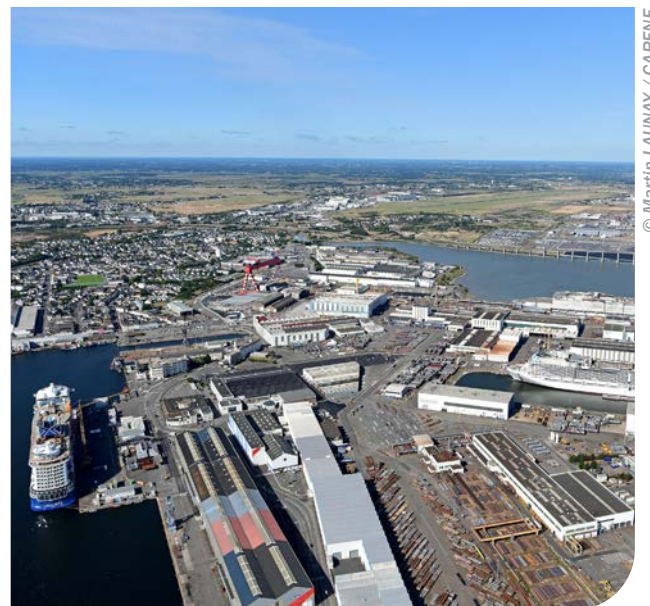
Entre bassins et Brivet, les chantiers navals et la Zone industrialo-Portuaire
