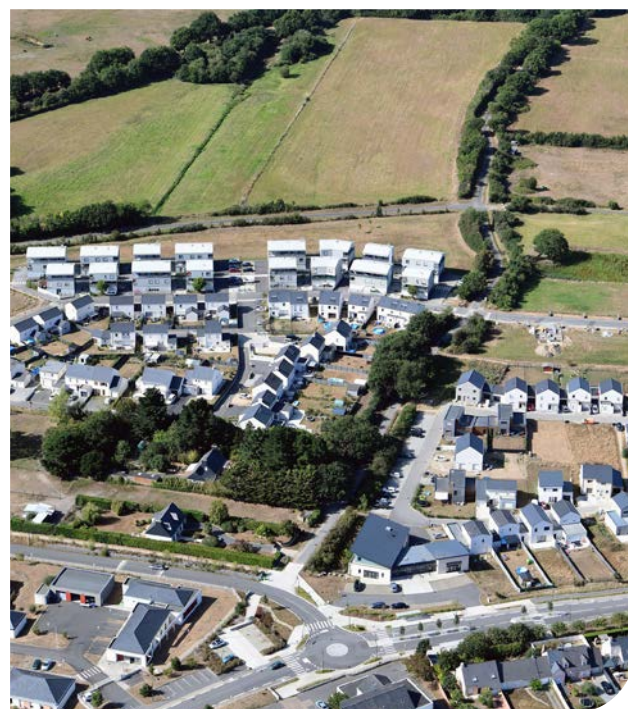
Réalisation en cours à la ZAC de l'Ormois
