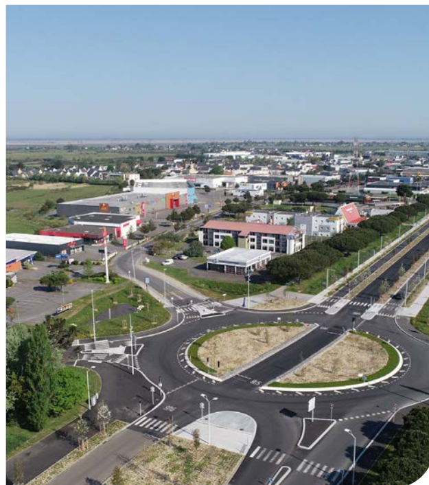
Entrée de la zone commerciale de Savine depuis le boulevard de l'Atlantique
