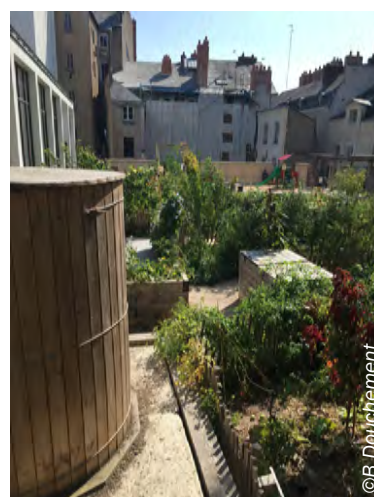
SQUARE GABRIEL CHÉREAU > collecte des eaux de toiture et compost partagé dans un square de quartier à Nantes. Usages : compost, espaces de plantation, jeux pour enfants, assises à l'ombre...
