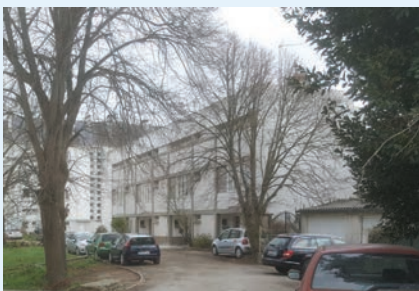
4. «Il y a quelques cas particuliers de cœurs d'îlots habités, c'est le cas ici. Le cœur d'îlot étant très grand, il a été construit. On a les pièces techniques au nord et un double niveau de loggias côté sud, avec les jardins.»
