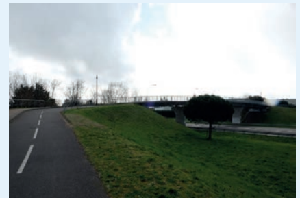
9. «Sur le quartier de Certé, le commerce de proximité c'est Auchan. On a des passerelles, on a des liaisons. Il y a la boulangerie de l'autre côté du boulevard de l'Atlantique, eh bien on traverse, on y va en vélo.»
