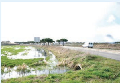
10. «C'est naturel, c'est la Brière. On est sur des nappes perchées. Les constructions n'ont pas eu d'incidences, parce que vous n'êtes pas sur les mêmes bassins versants.»
